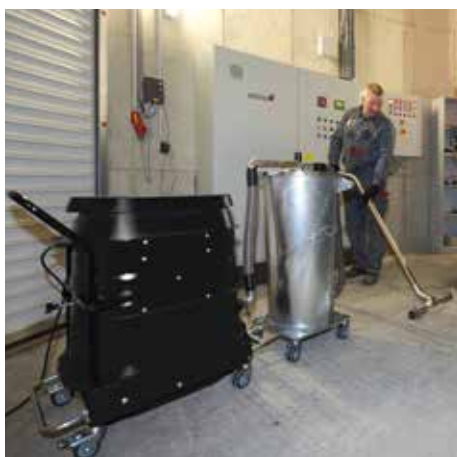
R01 A020 met voorafscheider in de warmtekrachtcentrale
